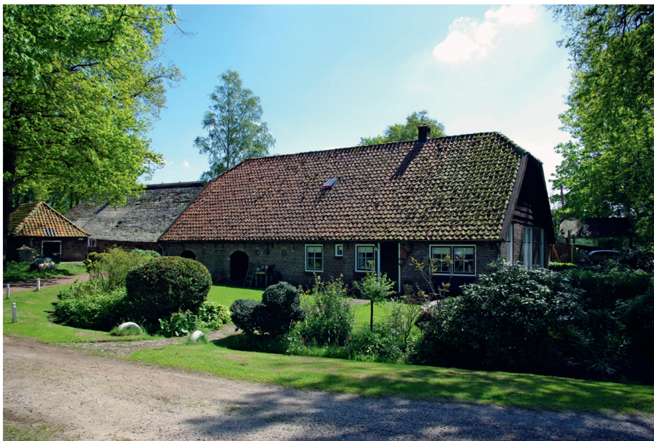
Afb. 15 De huidige boerderij De Poort vanuit het westen.
